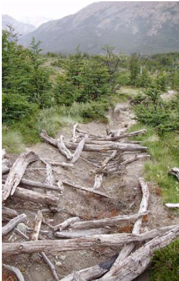
Cárcava antes de los arreglos
