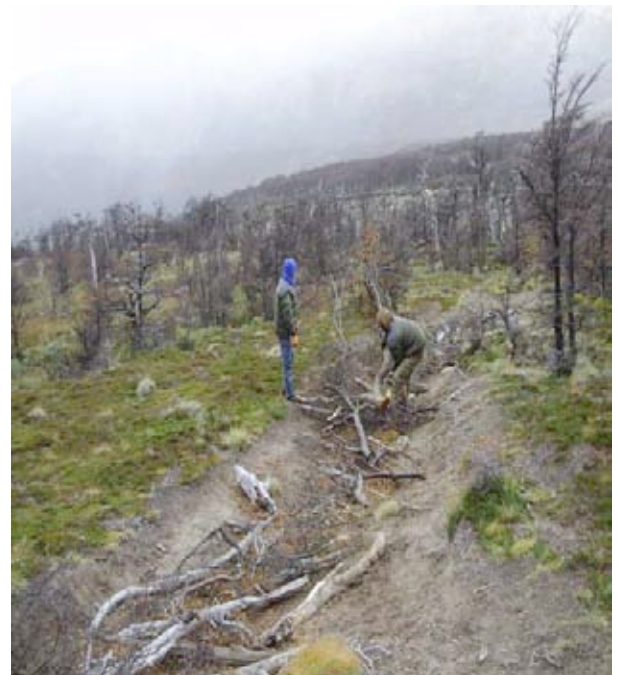
Cubriendo la cárcava con troncos y ramas
