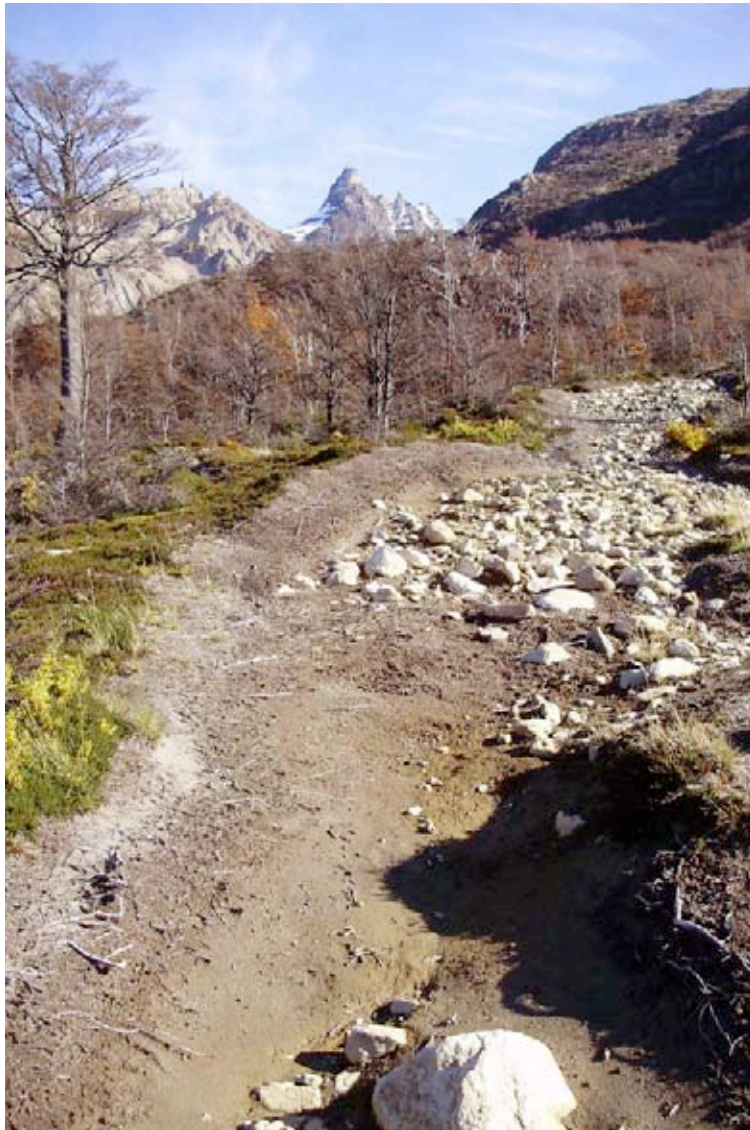
Corredor - Ladera desnuda antes de los arreglos
