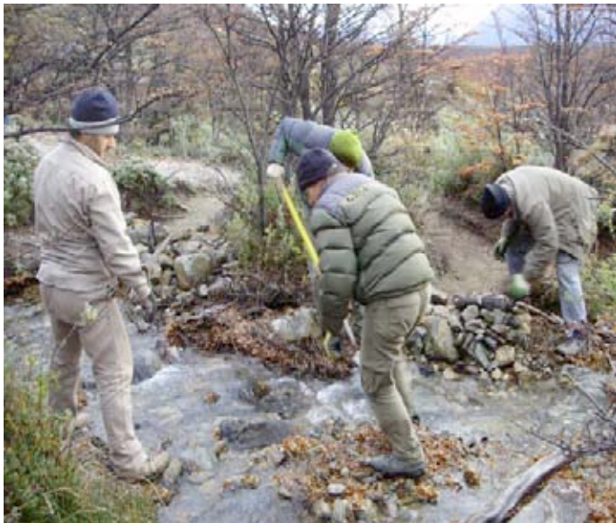
Armado de un dique en el arroyo sobre ladera pelada
