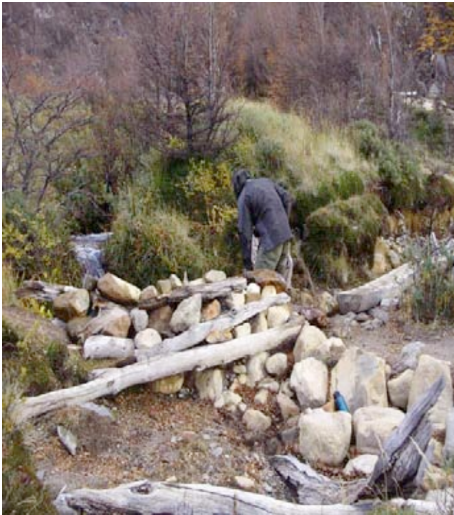
Refuerzo del dique
